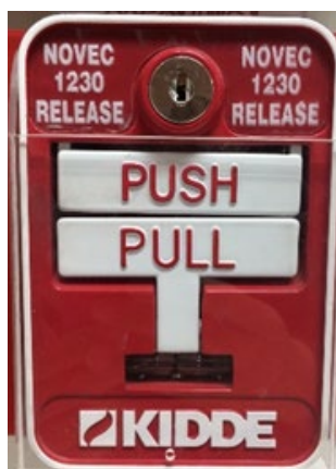
ภาพที่ 3.19 อุปกรณ์แจ้งสัญญาณแบบมือดึง
