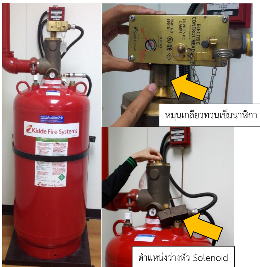
ภาพที่ 4.6 การถอดหัวถังดับเพลิง
