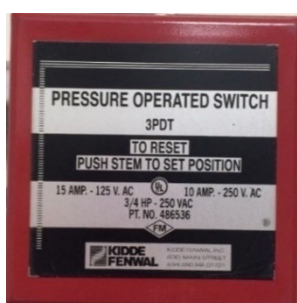
ภาพที่ 3.5 สวิตช์ควบคุมแรงดัน
