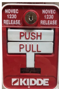
ภาพที่ 3.9 อุปกรณ์แจ้งสัญญาณแบบมือดึง
