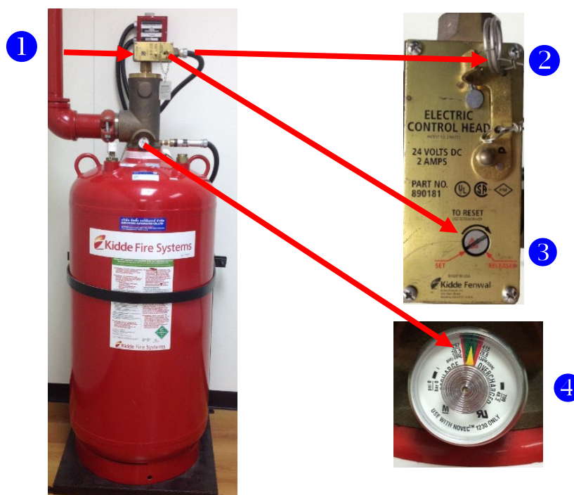
ภาพที่ 4.7 การตรวจสอบถังดับเพลิง
