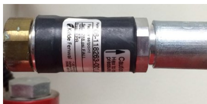
ภาพที่ 3.4 สวิตช์เช็คควาล์วแรงดัน
